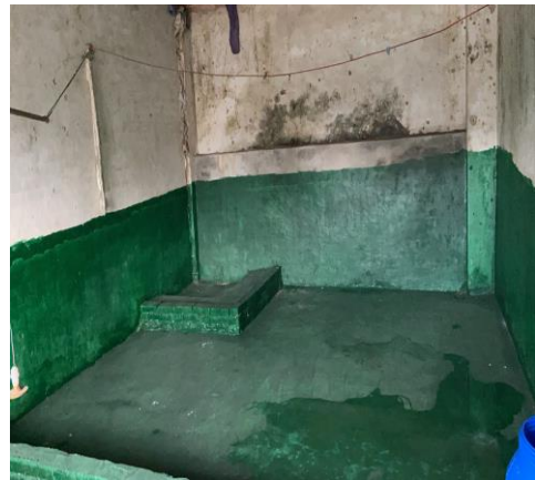
危废暂存间（内侧）
