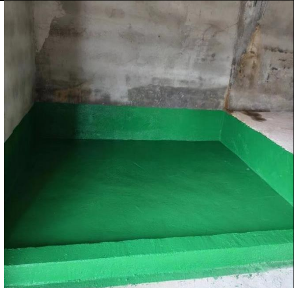
危废贮存间围堰
