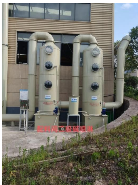
图 4.1-7 本次验收工程配料间废气二级碱喷淋、排气筒及采样口照片
