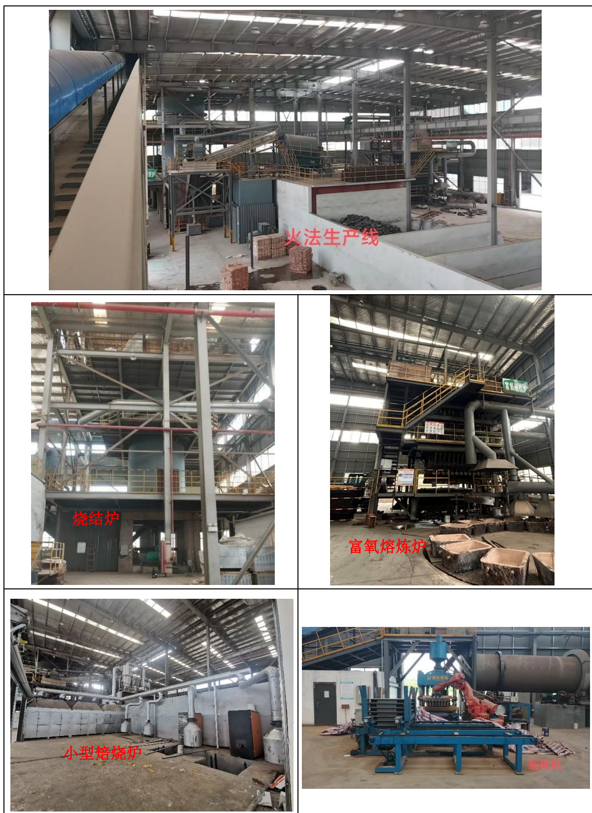
图 3.2-4 含重金属废物资源化利用处置系统部分主体工程设施照片
