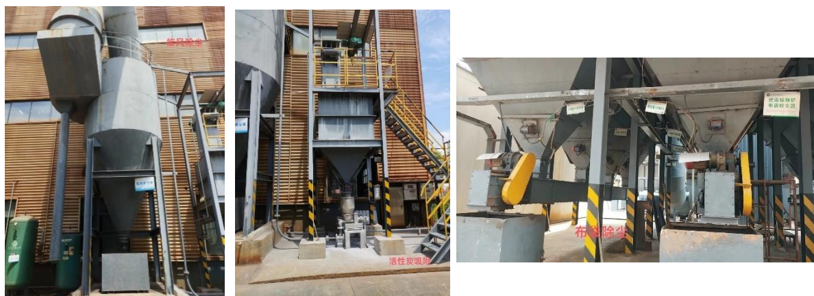
图 4.1-4 本次验收工程烧结炉废气旋风除尘、活性炭吸附、布袋除尘设施照片
