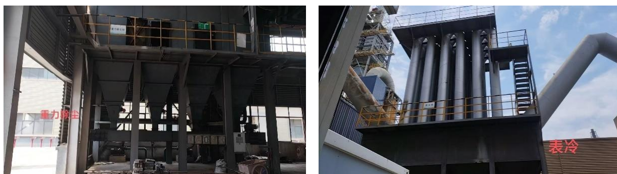
图 4.1-4 本次验收工程烧结炉废气旋风除尘、活性炭吸附、布袋除尘设施照片
