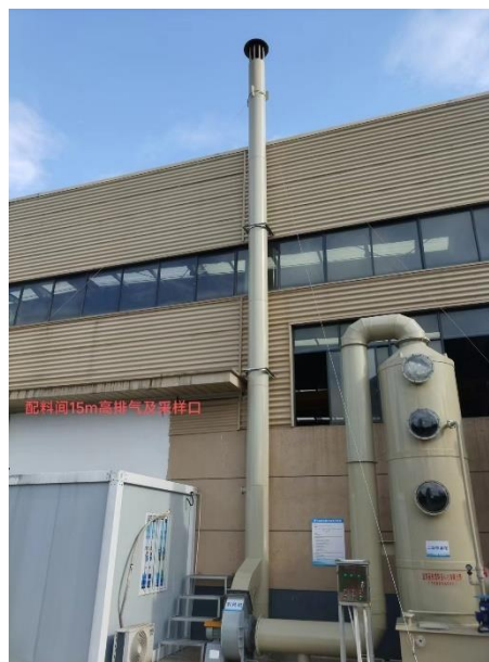
图 4.1-7 本次验收工程配料间废气二级碱喷淋、排气筒及采样口照片
